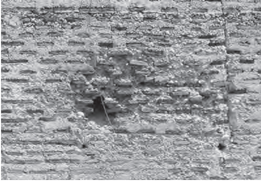
Figura 9 Imagen de detalle del muro de tapia valenciana.
