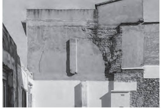
Figura 10 Imagen de la huella de la bóveda de cañón existente (El fabricante de esferas 2018)
