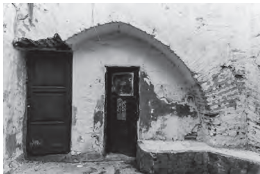
Figura 11 Imagen de las estructuras adosadas (El fabricante de esferas 2018).
