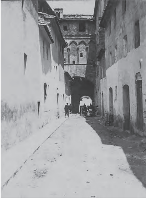
Figura 1 Fotografía del estado de conservación del palacio condal en 1920. Vista de la calle Palau (Fischer 1917-1920, 2R)
